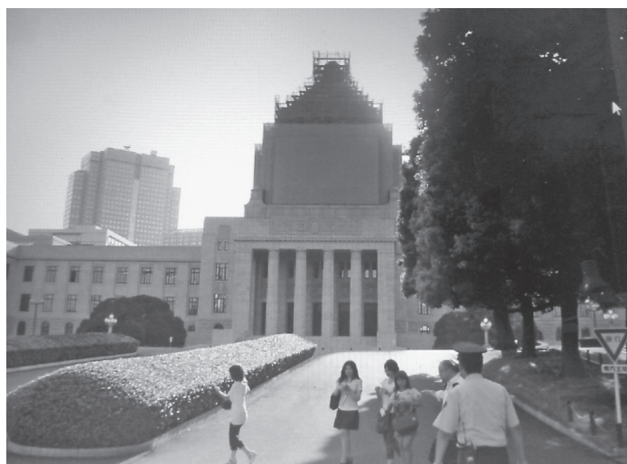
改装工事中の国会議事堂
